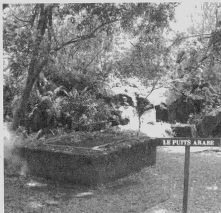
Le puits arabe : la margelle
