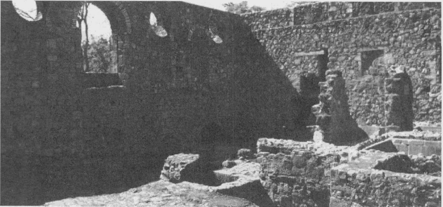
Intérieur de l'usine après travaux de conservation (au premier plan, turbine à sucre)
