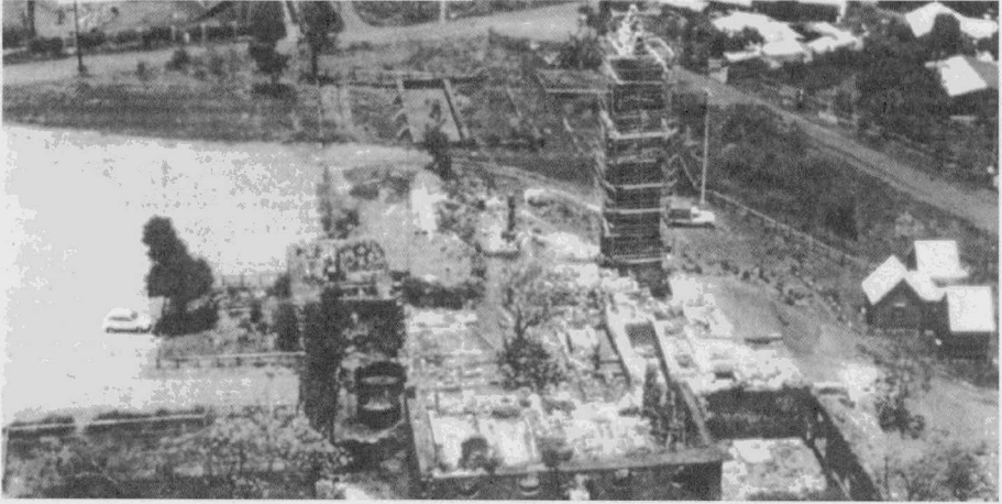
L'usine de Villèle, début 1992, après déblaiements et avant conservation (vue du S-E)
